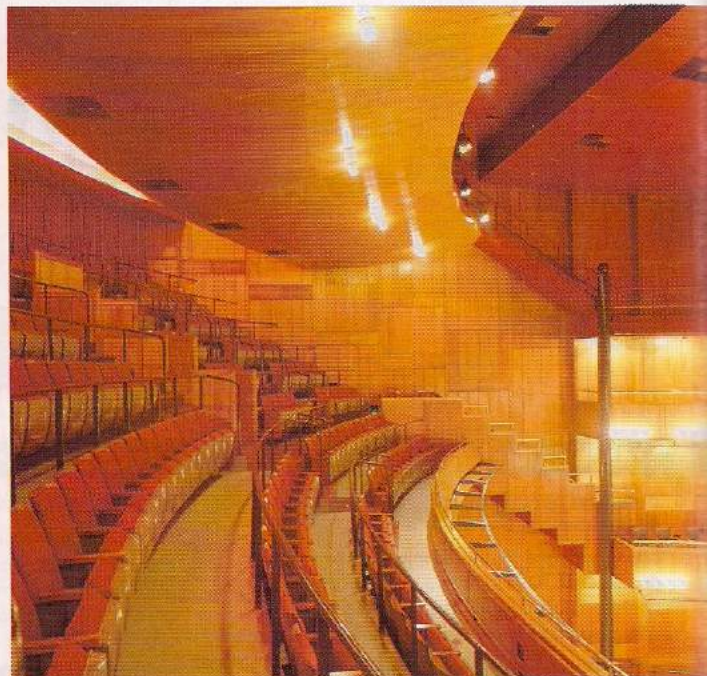
Platéia: revestimento de madeira, com painéis em formato adequado para otimizar o desempenho acústico. Poltronas da Irwin Seating Company projetadas especialmente para a sala, com larguras variáveis para perfeita adaptação à curvatura do corredor de acesso
